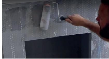
**2** Skamol Primer wird auf der Seite des SkamoEnclosure Board aufgetragen, auf der Putz aufgetragen werden soll.
