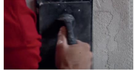
**3** Unmittelbar nach dem Auftragen von Skamol Primer kann Putz aufgetragen werden.
