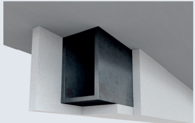
Dwarsbalk met gesloten profiel.
