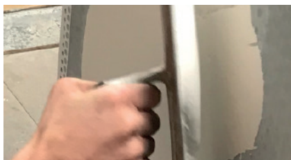
2 Mélanger et appliquer l'enduit épais Skamol Structural Plaster ou l'enduit fin Skamol Smooth Plaster, à l'endroit où la protection d'angle Skamol Corner doit être placée.
