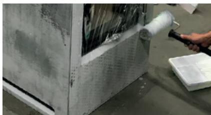
1 Préparer les plaques SkamoEnclosure Board.
