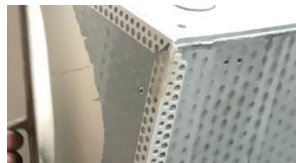
3 Presser la protection d'angle Skamol Corner sur l'enduit. Égaliser l'excédent d'enduit.
