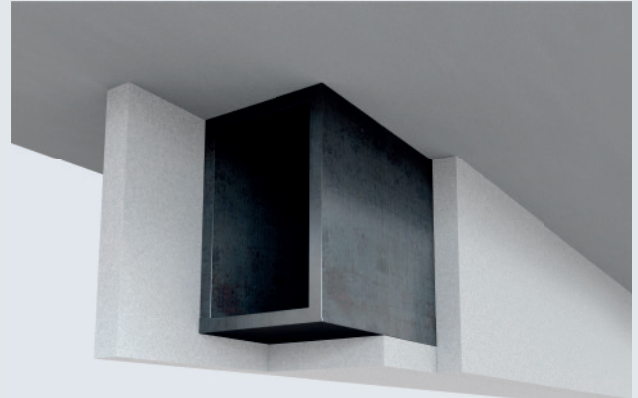
Viga con perfil cerrado.
