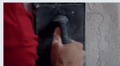
3 Omítku můžete aplikovat přibližně 30 minut po nanesení penetračního nátěru Skamol Primer.
