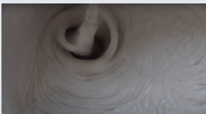
1 Смешайте штукатурку с водой в указанной пропорции.
