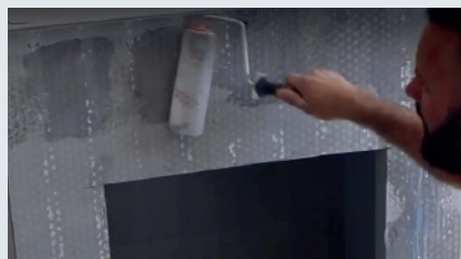
2 Нанесите грунтовку Skamol Primer на поверхность плиты SkamoEnclosure Board, на которую будет наноситься штукатурка.
