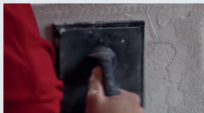
2 Нанесите штукатурку ровным по толщине слоем.
