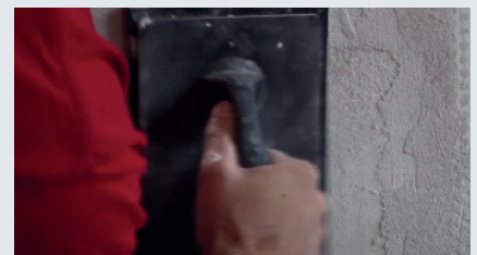
3 Штукатурку можно наносить примерно через 30 минут после нанесения грунтовки Skamol Primer.
