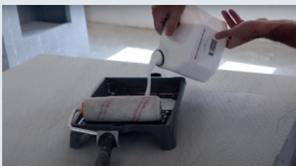
1 Грунтовка Skamol Primer готова к применению.
