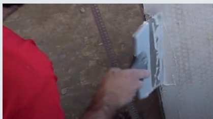
2 Påfør pudset, hvor der anvendes Skamol Corner.
