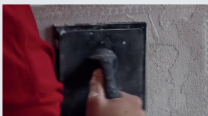
2 Appliquez une couche uniforme d'enduit.
