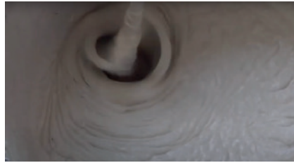
2 Smíchejte hladkou omítku Skamol Smooth Plaster s vodou podle uvedeného směšovacího poměru.
