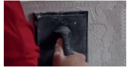
3 Naneste hladkou omítku Skamol Smooth Plaster v rovnoměrné vrstvě o tloušťce 1,5–3mm.
