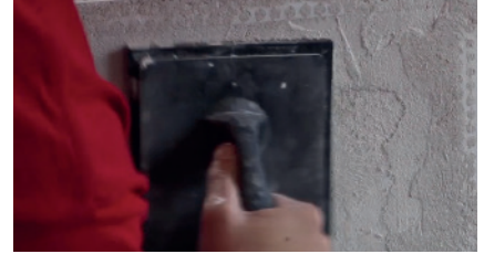
3 Påfør Skamol Smooth Plaster i en jævn tykkelse på 1,5 til 3mm.
